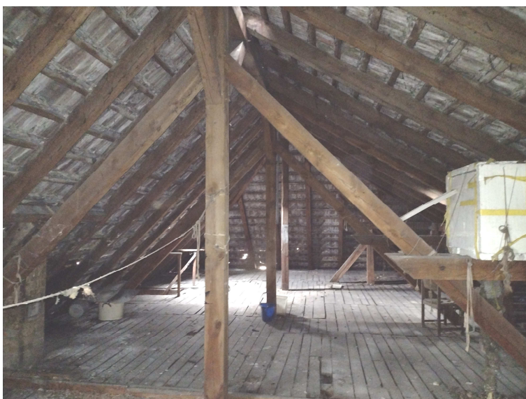
Fot. nr 5 Widok strychu i konstrukcji dachowej
