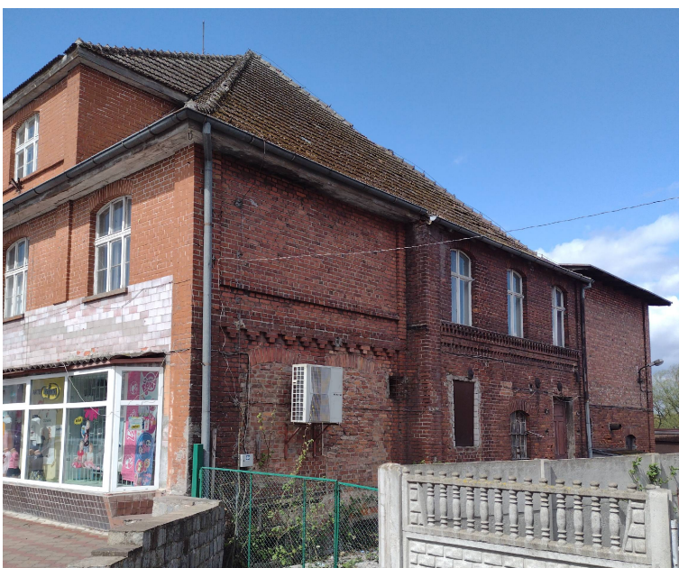
Fot. nr 3 Elewacja szczytowa 1 (północno-wschodnia)
