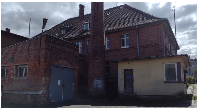
Fot. nr 2 Elewacja tylna (północno-zachodnia)
