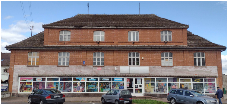
Fot. nr 1 Elewacja frontowa (południowo-wschodnia)
